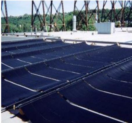
Fig. 2.20 Capteurs solaires sans vitrage (capteur moquette). [19]
