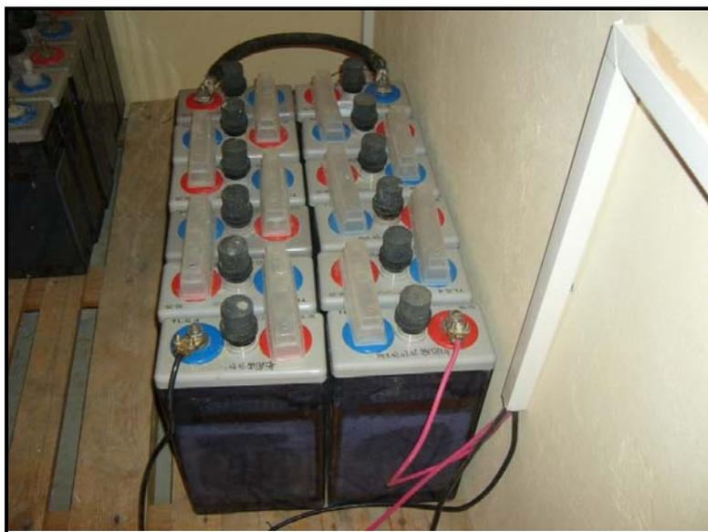
**Figure 2.15.** Système de stockage (Batteries TLS4) posé sur une palette en bois
