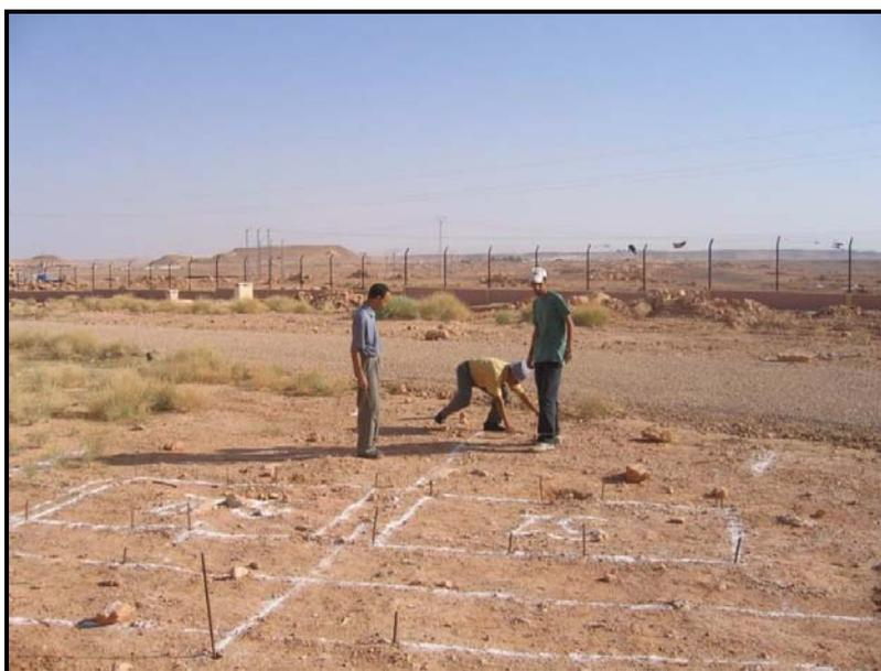
**Figure 2.11.** Tracé sur le lieu d'installation du générateur PV
