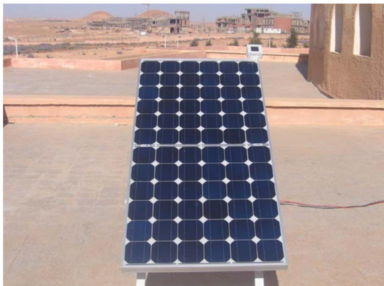
**Figure 2.1.** Module PV en groupement série - parallèle des cellules
