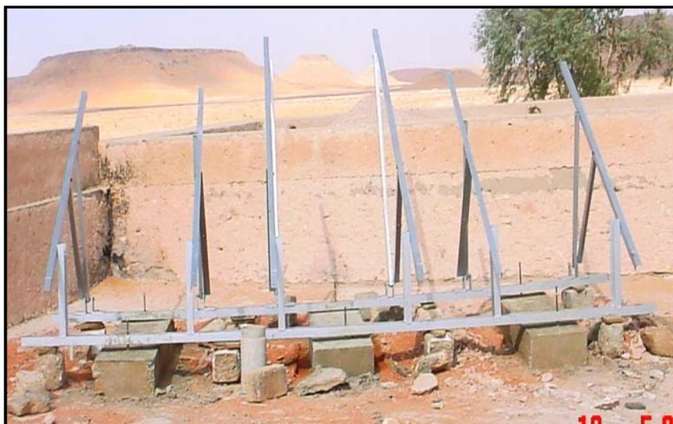
**Figure 2.13.** Structure porteuse fixée sur des socles en béton
