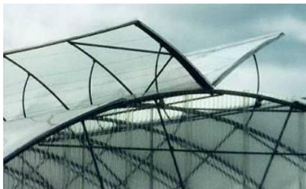
Fig.2.22.: Système d'aération des serres (Ouvrants en Toiture)
