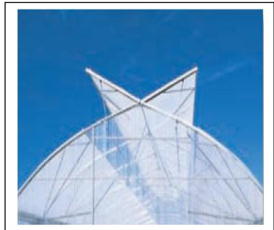
Fig. 2.11 : Aération par double versant
