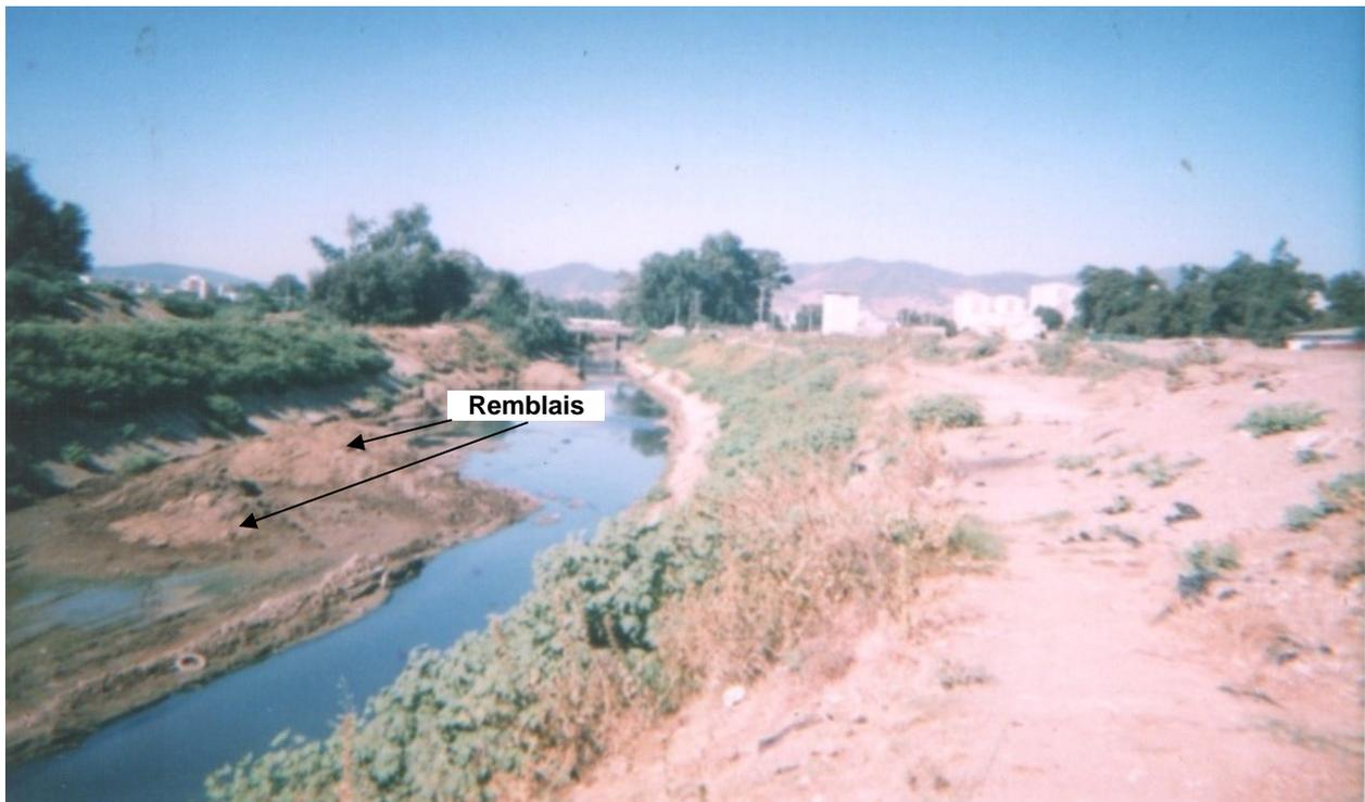
Photo 4, le jet des remblais dans les cours d'eau aboutit à des inondations liées aux embâcles (oued Zeramna prêt de la zone industrielle – août 2005)
