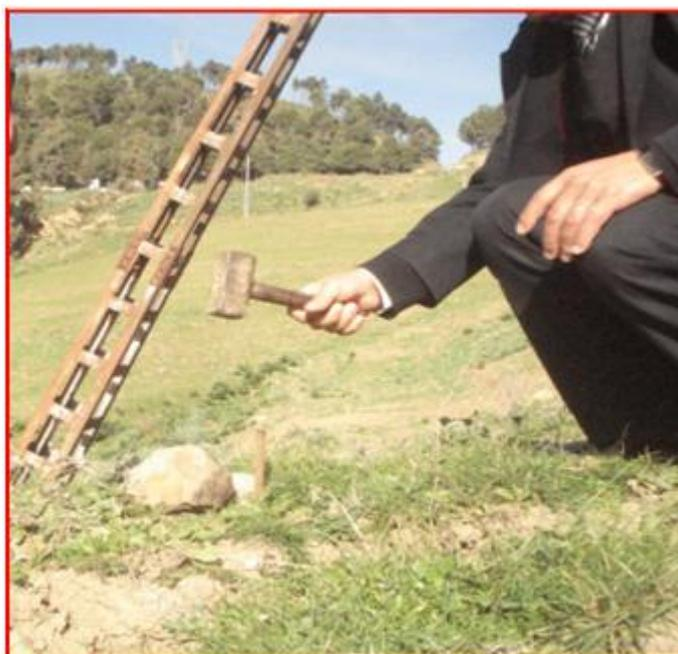
*Photo. IV.4. Implantation des piquets en acier dans la zone de glissement (31-12-2009)*
