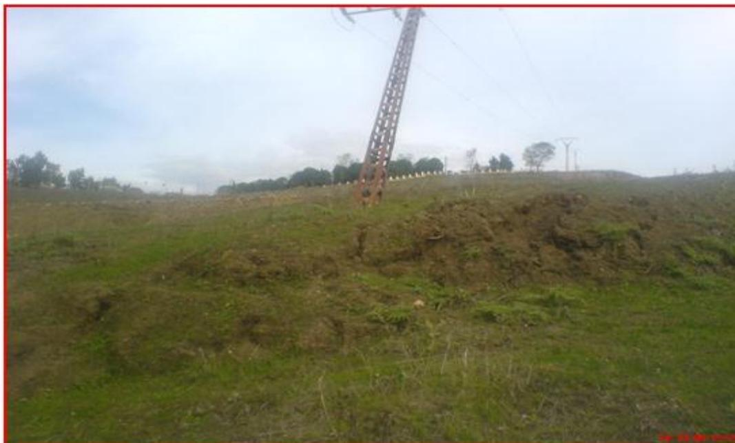
*Photo. IV .2. Inclinaison de poteau électrique de haute tension suite à l'activation de glissement de terrain. ( 14/10/2009- 15<sup>h</sup> :34)*
