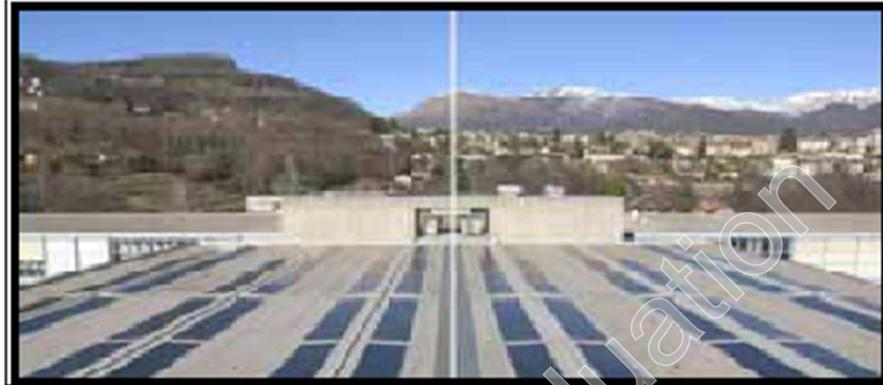
**Figure 1-13: Intégration de 900 m<sup>2</sup> de modules PV Sarnasol sur la toiture (inclinée à 20°) d'une école à Lugano en Suisse (12 branches de 5 modules PV Sarnasol) [6]**
