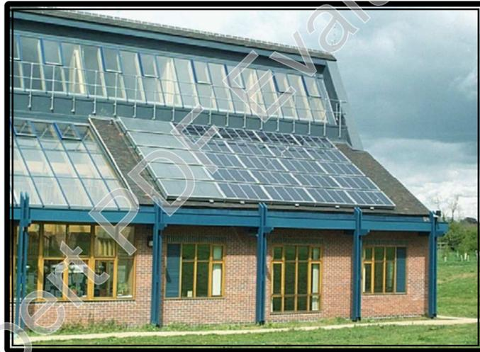
**Figure 3-5: Capteurs solaires combinés intégrés à la toiture du Brockhill Environment Center**
