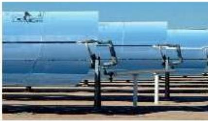
Capteurs thermodynamique cylindro-paraboliques
