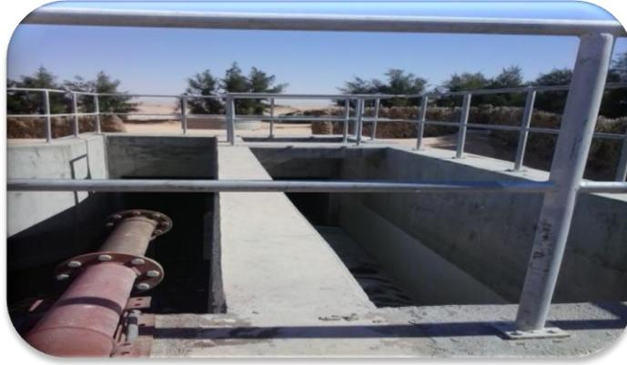
**Figure 18 : Canales de transport des eaux usées (à gauche) et des eaux de drainage (à droite).**
