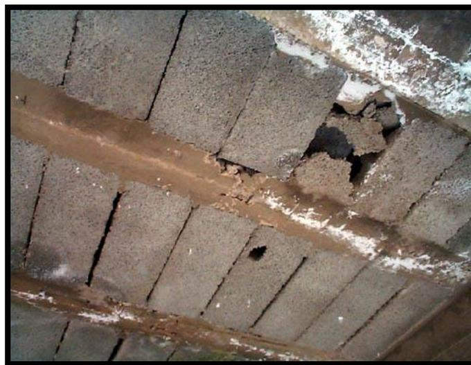
Figure 167: plafond qui reflète la qualité médiocre du bâti source : [www.lanouvelleville.com](http://www.lanouvelleville.com)
