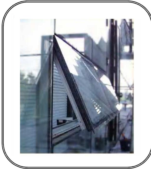
**Figure 1.9 : Exemple d’ouvrant motorisé dans une double façade ventilée naturellement permettant le passage d’un mode de ventilation à un autre.**
